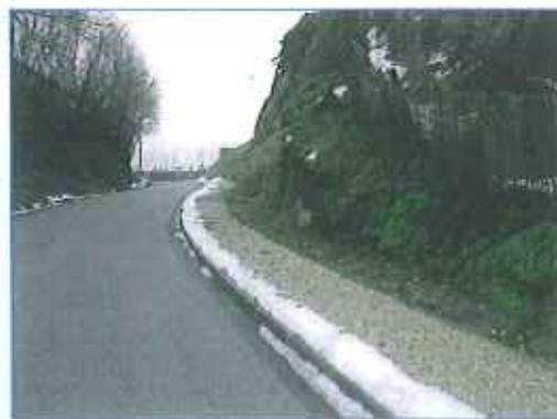
de fortes pluies qui ont provoqué des écoulements importants de gravasse sur la départementale. La stabilisation du terrain a permis la finition des travaux.
